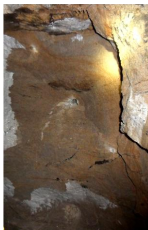
Rys. 8. Wyrwany stożek skalny [4]
