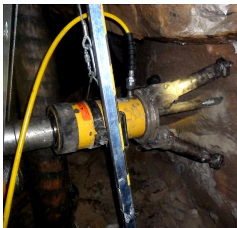
Rys. 7. Wrywanie calizny skalnej przy użyciu kotwy samopodcinającej HDA-P [4]
